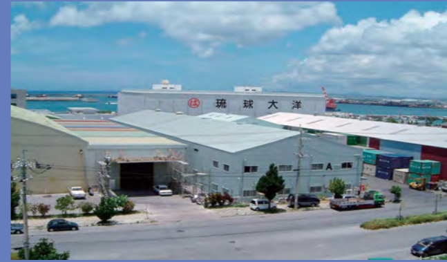
港町倉庫(那覇市港町)
